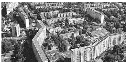
W tym czasie zbudowano na Bałutach np. osiedle im. Władysława Jagiełły
