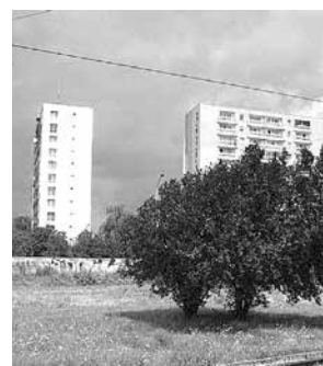
W trudnych czasach udało się oddać do użytku wieżowce i bloki na Chojnach
