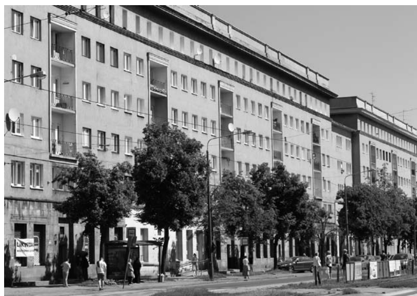
Okazale bloki w stylu socrealistycznym wybudowano w rejonie ul. Wojska Polskiego.
