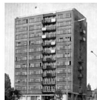
Wieżowce i wysokościami są znakiem budownictwa epoki „gierkowskiej”.
