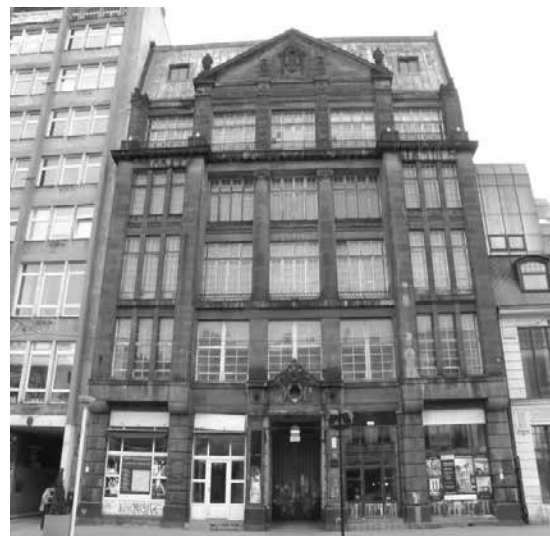
Dawna kamienica Siemens, Piotrkowska 96. Tu zainstalował się pierwszy w nowej Polsce koncern wydawniczy. Przez kolejne 40 lat w tym budynku pracowały redakcje łódzkich gazet.
