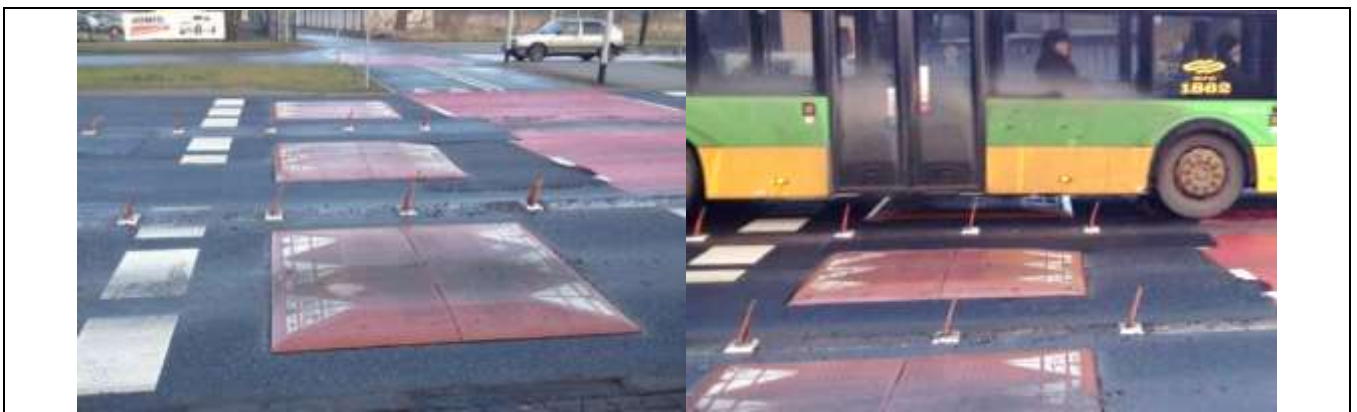
Rys. 23 Poduszki berlińskie - specjalny próg spowalniający ruch pojazdów osobowych. Poduszki berlińskie są wąskimi wyniesieniami, umożliwiającymi niezakłócony przejazd pojazdom ciężkim np. autobusom komunikacji miejskiej - rozstaw kół jest szerszy niż wymiar poduszki (materiały własne)
