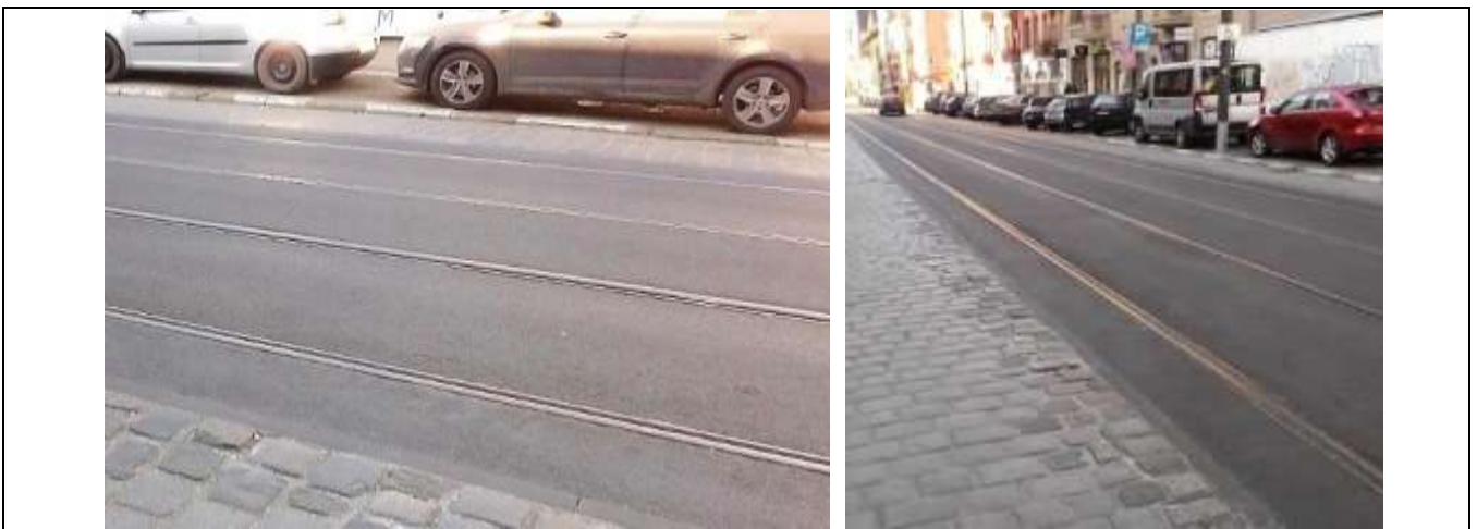
Rys. 29 Przykład zmodernizowanej drogi – częściowa wymiana nawierzchni w jezdni z kostki na asfalt wzdłuż torowiska tramwajowego umożliwia cichszy przejazd samochodem (materiały własne)
