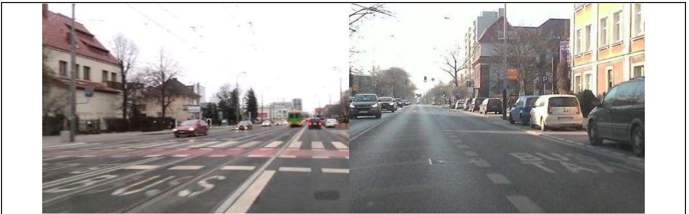
Rys. 19 Drogi rowerowe, buspasy, wydzielone torowisko w jezdni, redukcja pasów ruchu dla pojazdów osobowych do jednego na kierunek (materiały własne)
