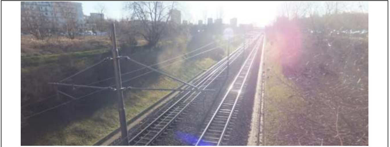
Rys. 46 Wały ziemne wzdłuż linii tramwajowej; torowisko zlokalizowane jest poniżej poziomu terenu na którym znajduje się zabudowa mieszkaniowa (materiały własne)
