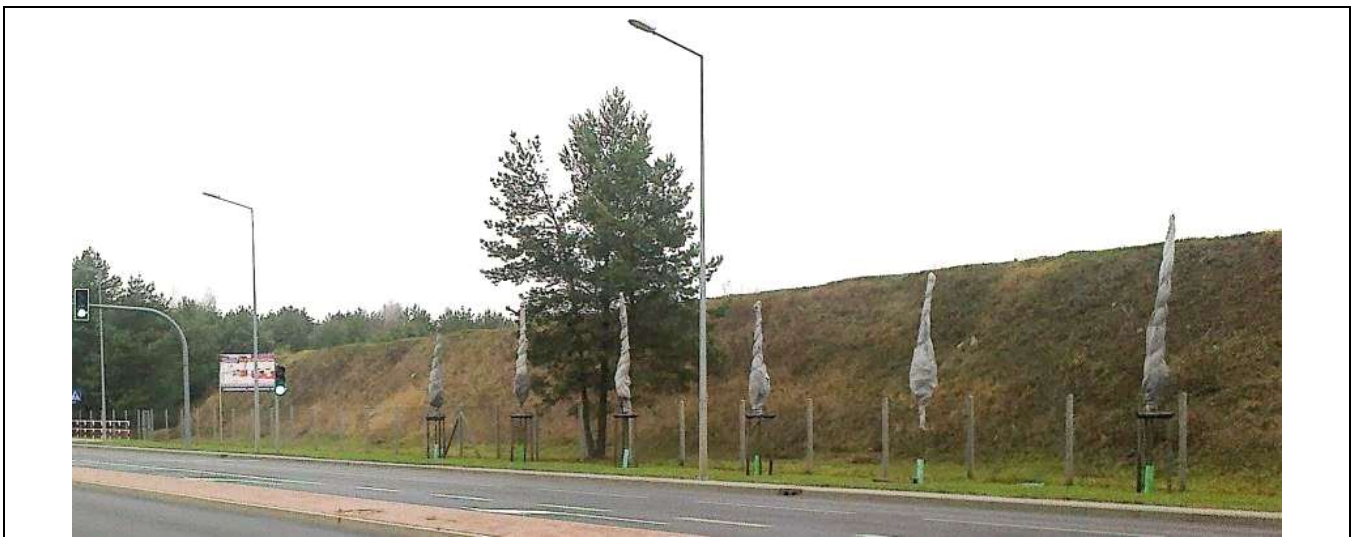
Rys. 47 Przykład wału ziemnego przy drodze (materiały własne)
