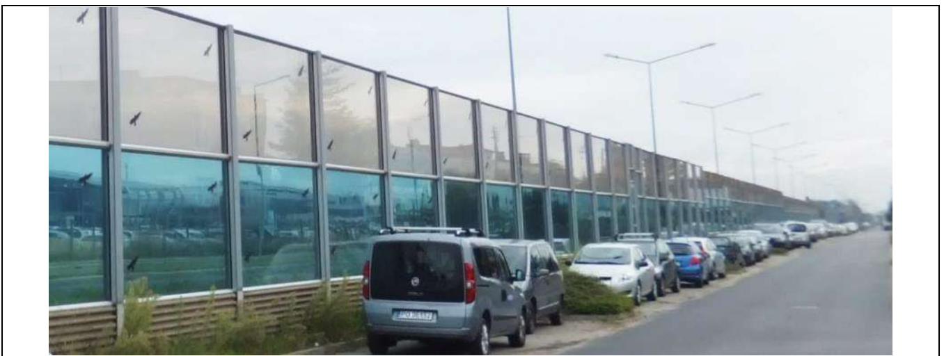
Rys. 38 Ekran przeciwhałasowy odbijający zbudowany z szkła akrylowego i keramzytobetonu u podstawy (materiały własne)
