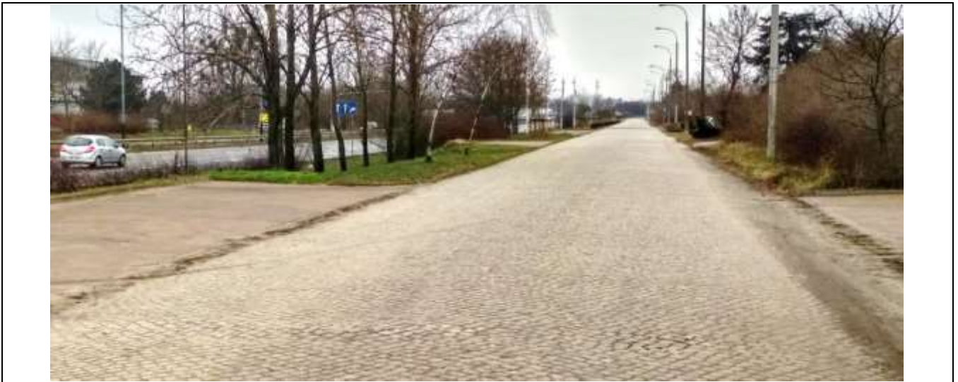
Rys. 28 Przykład drogi o nawierzchni z kostki brukowej. Emisja hałasu pojazdu poruszającego się po tego rodzaju nawierzchni jest większa o ok. 3 dB względem ruchu na asfaltobetonie przy zachowaniu tej samej prędkości (dane na podstawie NMPB-Routes-08, zdjęcie – materiały własne)
