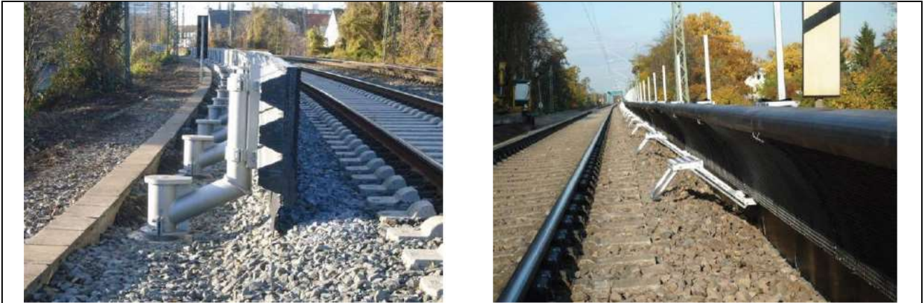
Rys. 44 Niski ekran przeciwhałasowy, nieodchylany (źródło: DB Netze: Innovative Maßnahmen zum Lärm- und Erschütterungsschutz am Fahrweg, Schlussbericht, 2012)
