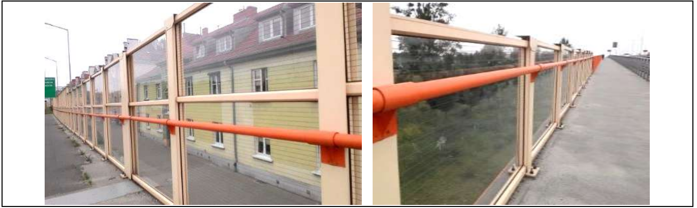
Rys. 40 Przezierny ekran przeciwhałasowy odbijający o lekkiej konstrukcji na wiadukcie (materiały własne)
