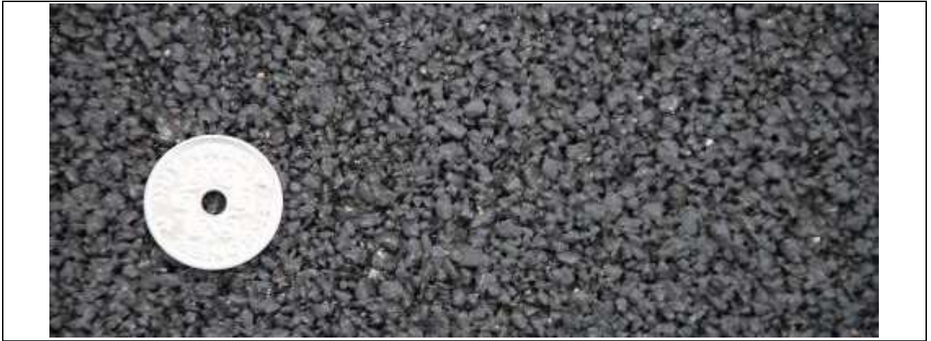
Rys. 27 Struktura nawierzchni jednowarstwowej (źródło: DVS-DRI Super Quiet Traffic International search for pavement providing 10 dB noise reduction, Danish Road Institute Report nr 178, 2009)
