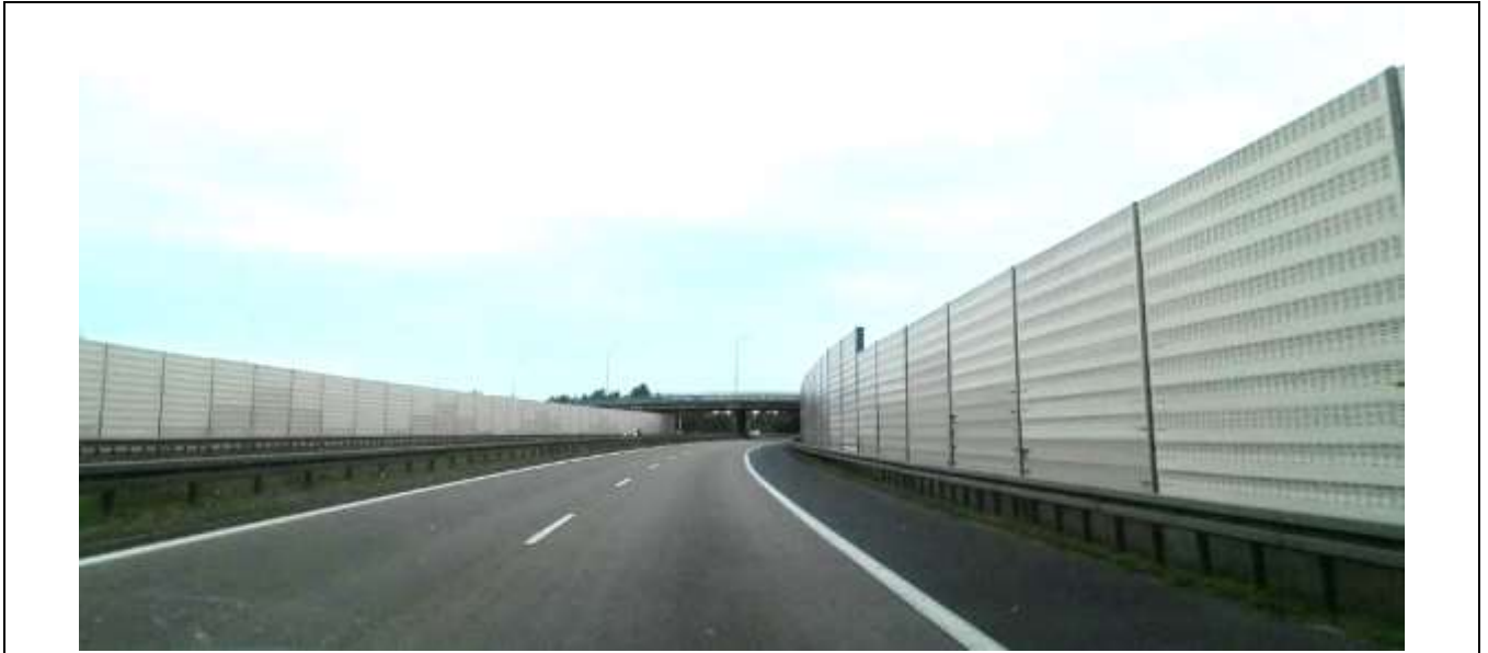
Rys. 42 Ekran przeciwhałasowe pochłaniające zbudowane z kasetonów (materiały własne)
