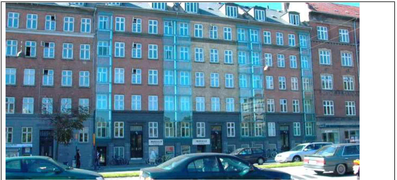
Rys. 52 Elewacje szklane przy fasadach pomieszczeń sypialnianych budynku ulokowanego tuż przy drodze głównej; brak miejsca na budowę ekranu akustycznego (źródło: jw.).
