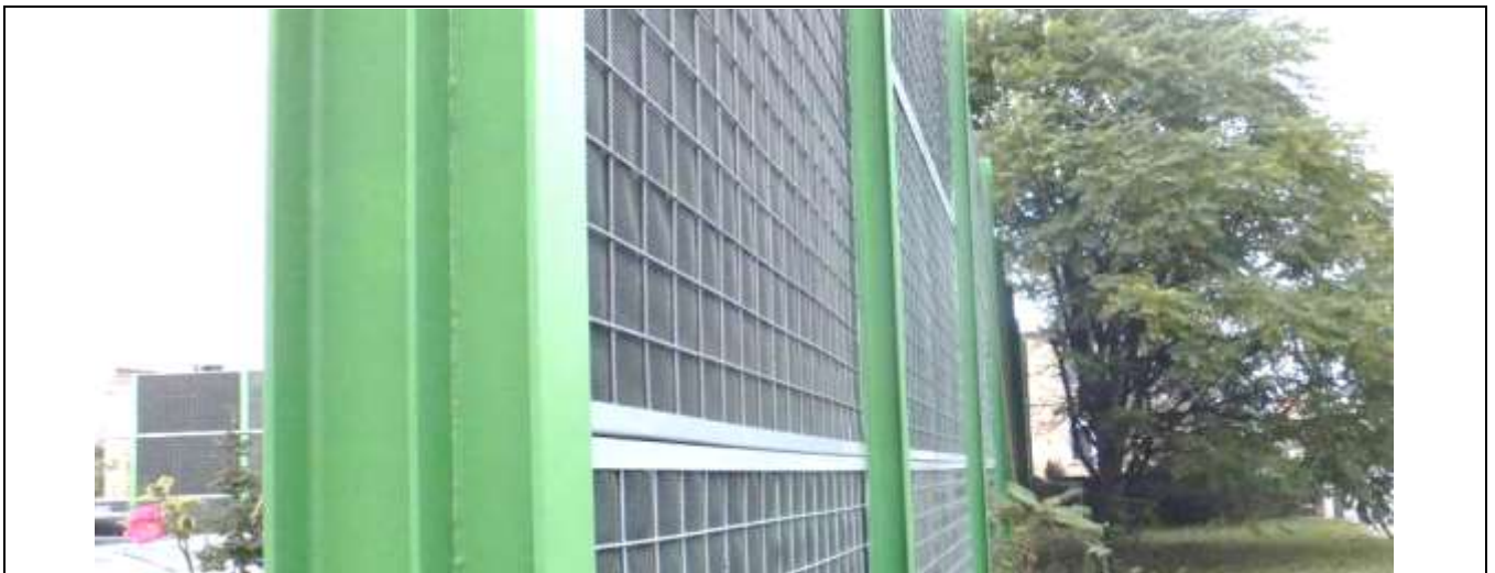
Rys. 41 Ekran przeciwhałasowy pochłaniający zbudowany z siatki z prętów stalowych oraz siatki z polietylenu, wewnątrz z wełny mineralnej i płyty drzazgowo-cementowej (materiały własne)
