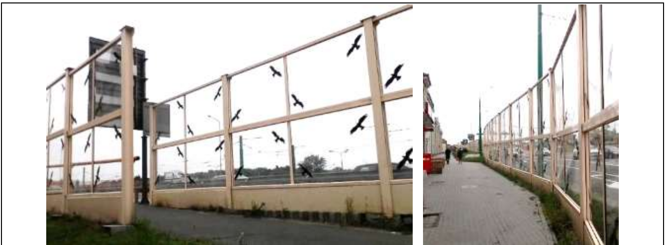
Rys. 39 Przejrzyste ekrany przeciwhałasowe odbijające (na zakładkę) w pobliżu zabudowy mieszkaniowej (materiały własne)
